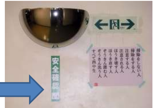
ミラーの下に注意喚起のシールが（矢印部分）
