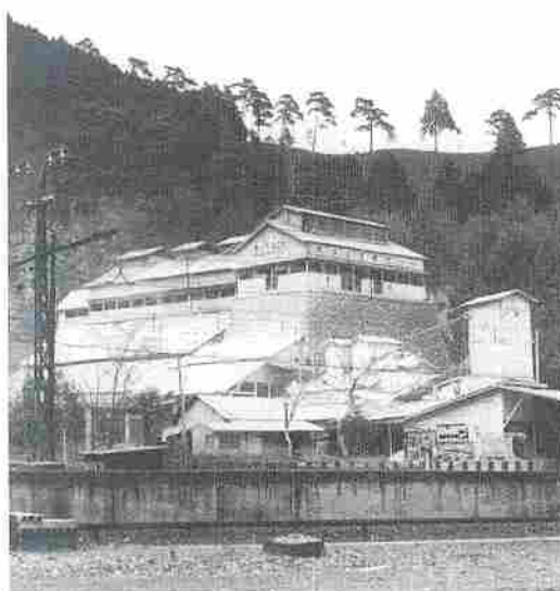
石灰石採掘場（昭和30年頃）
